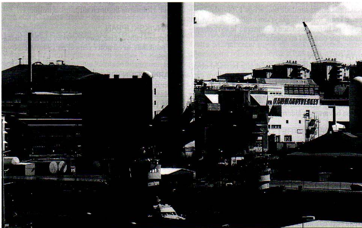
Fjärrvärmearnläggning vid Hammarbyverket
